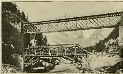
Abb. 146. Gitterbrücke bei Kastenreith. [Kronprinz Rudolf-Bahn.]
